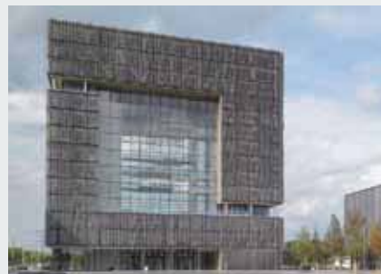
Главный офис компании ThyssenKrupp AG, Эссен
