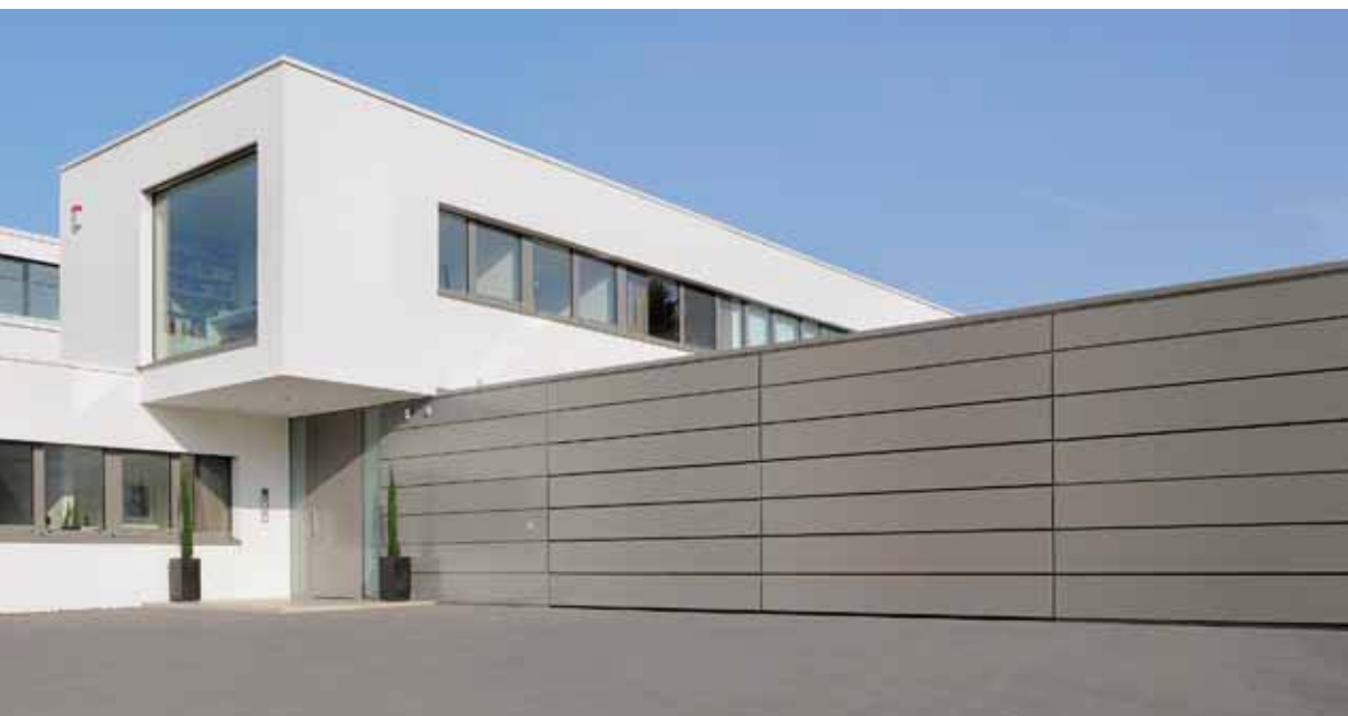
Облицовка алюминиевой соединительной пластиной, выполняемая заказчиком
