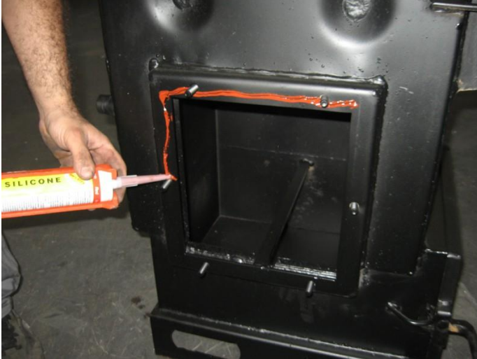
Малюнок 15 - Нанесення жаростійкого силікону перед встановленням прокладки.
