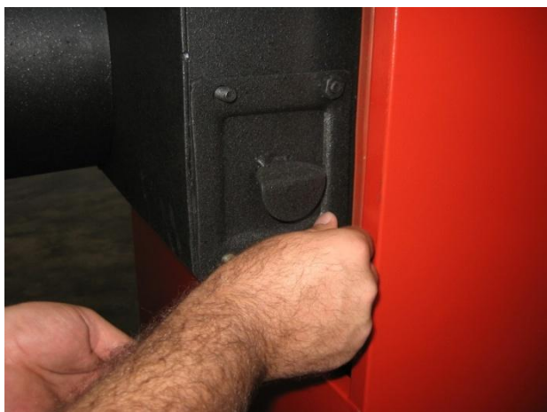
Малюнок 10 - Зняття заглушки для чищення адаптера диму
