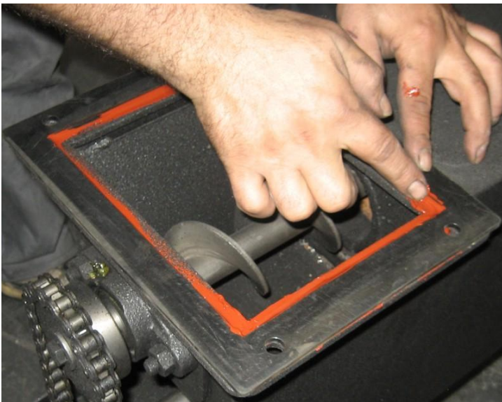
Малюнок 18 - Встановлення прокладки між бункером і корпусом шнекової подачі.
