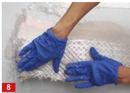
8 І знову додайте другий шар з Тривісного волокна A1 на вологий шар A1
