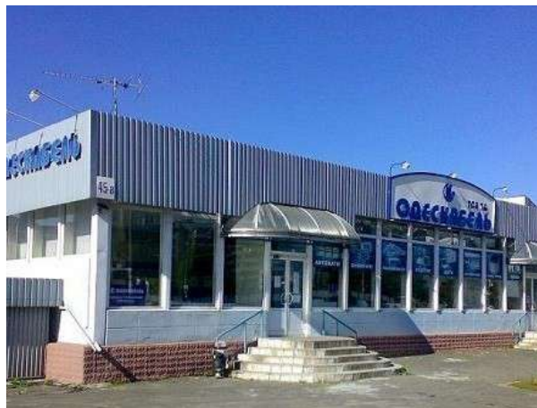
Виробнича будівля «Одеський кабельний завод», м. Одеса, 2 000 м 2
