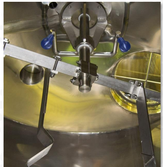
Для покрытия теневых зон использую несколько моющих форсунок
