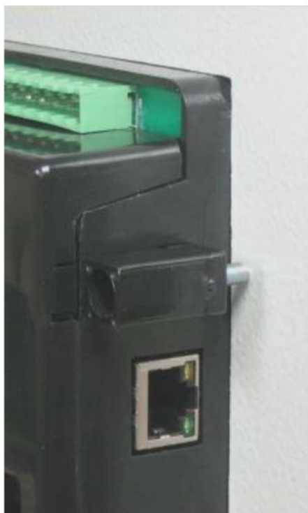
Установка винтового кронштейна
