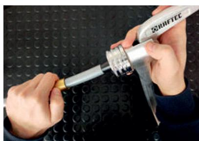
3. Виконати розкалібрування трубы за допомогою ручного або акумуляторного розширювача:
