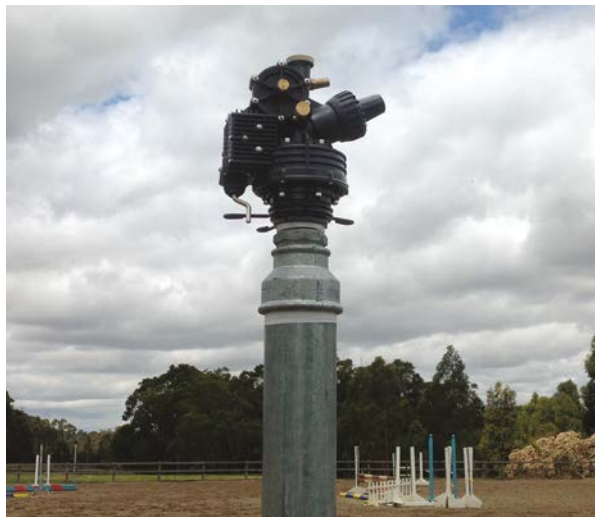
Ротор ST-1600-HS-BR в Установленном Состоянии
