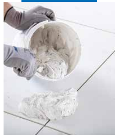
Нанесення кремоподібного однорідного розчину
