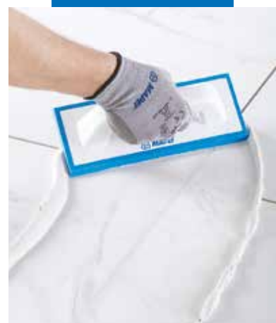
Легке нанесення епоксидного заповнювача швів
