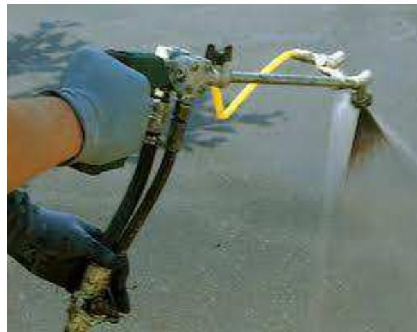
Сиолит Б1К наносится равномерно на подготовленную поверхность при помощи кисти, валика или распылителя, толщиной 1 слоя не более 1мм. Время сушки до нанесения следующего слоя 6-8 часов при  $t = 20^{\circ}\text{C}$ .
