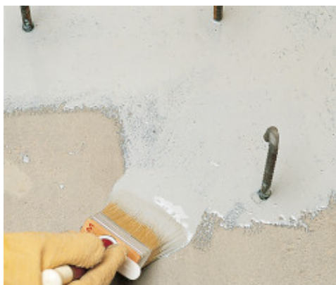
Нанесение Eporip кистью на рабочий шов бетонирования
