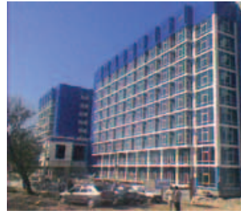
Гостинично-жилой комплекс «Акварин», г. Севастополь, (цоколь, 2500 м 2 )
