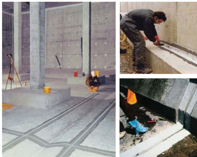
гидроизоляция трещин
