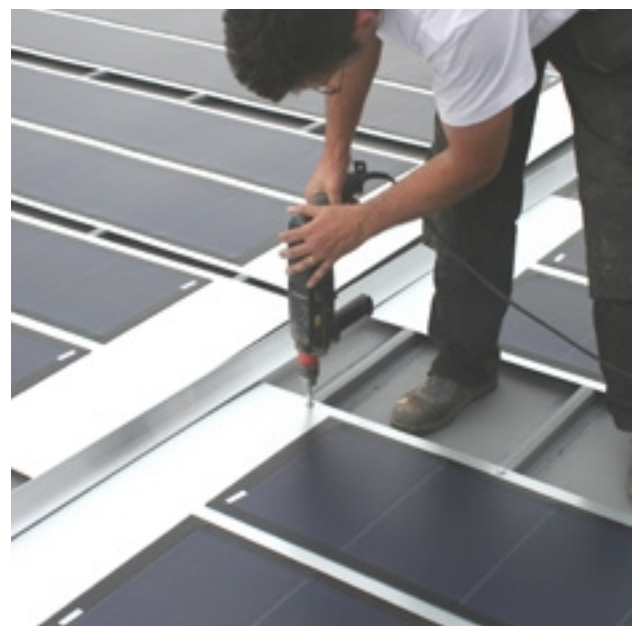
Заміна панелей без ризику пошкодити покрівельну мембрану.
