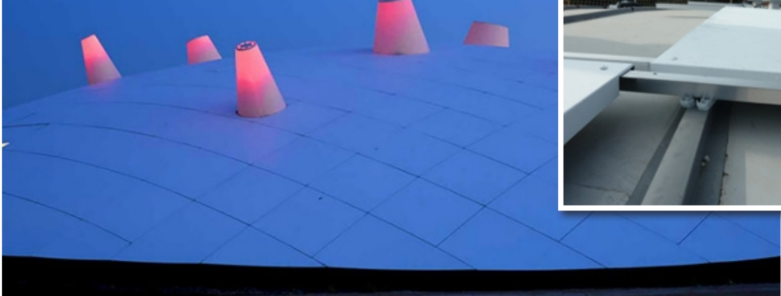
Океанополіс - Франція Профілі RENOLIT ALKORSOLAR як основа для алюмінієвих листів
