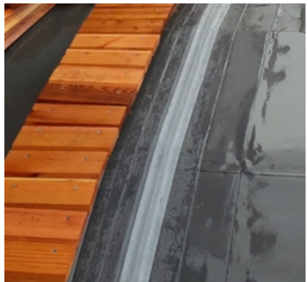
Дерев'яні планки закріплені на профілях RENOLIT ALKORSOLAR.
