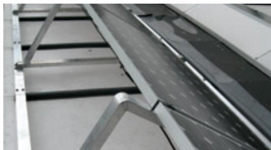
Рисунок 6: RENOLIT ALKORSOLAR как основание для кристаллических фотогальванических панелей
