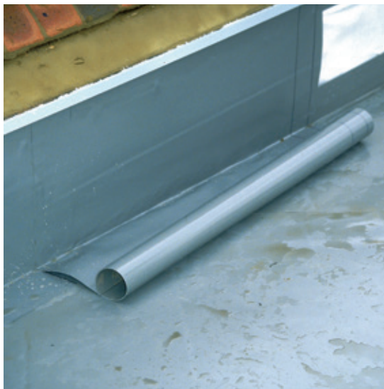
Рис. 3: Ограничитель кромок из листового металла RENOLIT ALKORPLAN 81170
