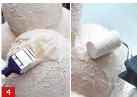
4 А1 можна наносити пензлем, валиком, шпателем або ракелем
