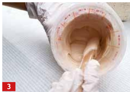
3 Змішайте А1 Смола, Thix A і А1 Порошок, щоб отримати однорідний матеріал
