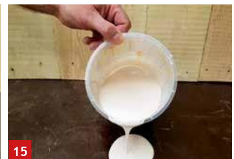
15 A1 готовий до ламінування, лиття або обприскування. Час переробки 20 - 25 хвилин
