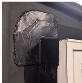
Рис. 1. Кут ME241 EPDM показаний приклеєним після застосування ME220 VV (приклеювання за допомогою OT015)
