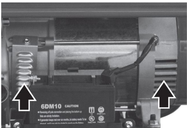
Впускні та випускні отвори охолоджувального повітря генератора змінного струму Загальне очищення генератора. Очистіть всі інші поверхні вологою ганчіркою.
