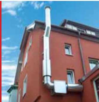
Наружный монтаж при помощи стенового кронштейна (комплектующие).
