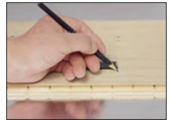
Die letzte Diele der ersten Reihe wird unter Beachtung des Wandabstands auf die notwendige Länge gekürzt. Das abgeschnittene Stück der Diele wird als Beginn der zweiten Reihe verwendet.
