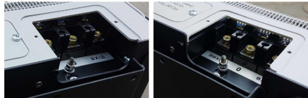
5. Зачистить, оборудовать наконечником провод защитного заземления и закрепить его гайкой на винте рядом с клеммником в отсеке клеммника.
