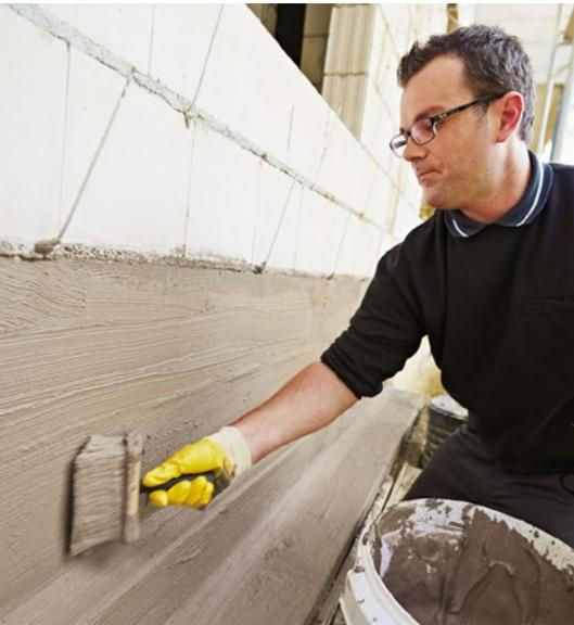
INTRASIT® Poly-C1 54Z ist eine pastöse, gut haftende Abdichtungsmasse auf Polymer-Zementbasis. Nach dem Anrühren der beiden Komponenten erhält man einen gut spachtelfähigen, nach Zugabe von 1 % Wasser streichfähigen PCC-Mörtel.
