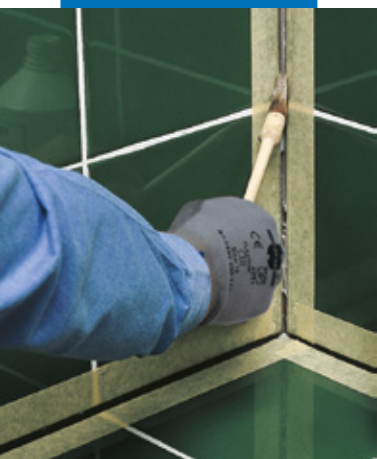
Нанесення Primer FD
