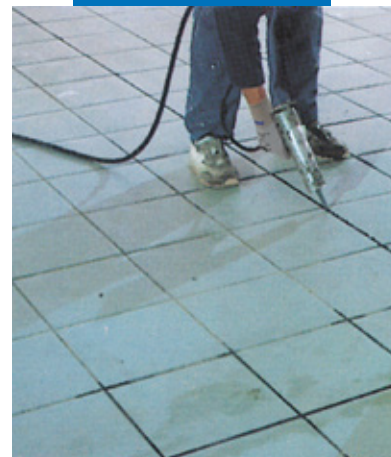
Герметизація швів керамічного підлогового покриття за допомогою Mapesil AC
