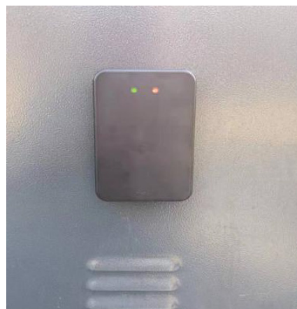
(d) Front display after installation
