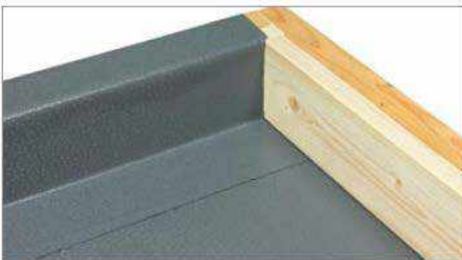
31. "Перший" парапет, що примикає до кута накрити полотном мембрани так, щоб мембрана закінчувалася врівень з вертикальним кутом. Приваріть це полотно до основного килима.
