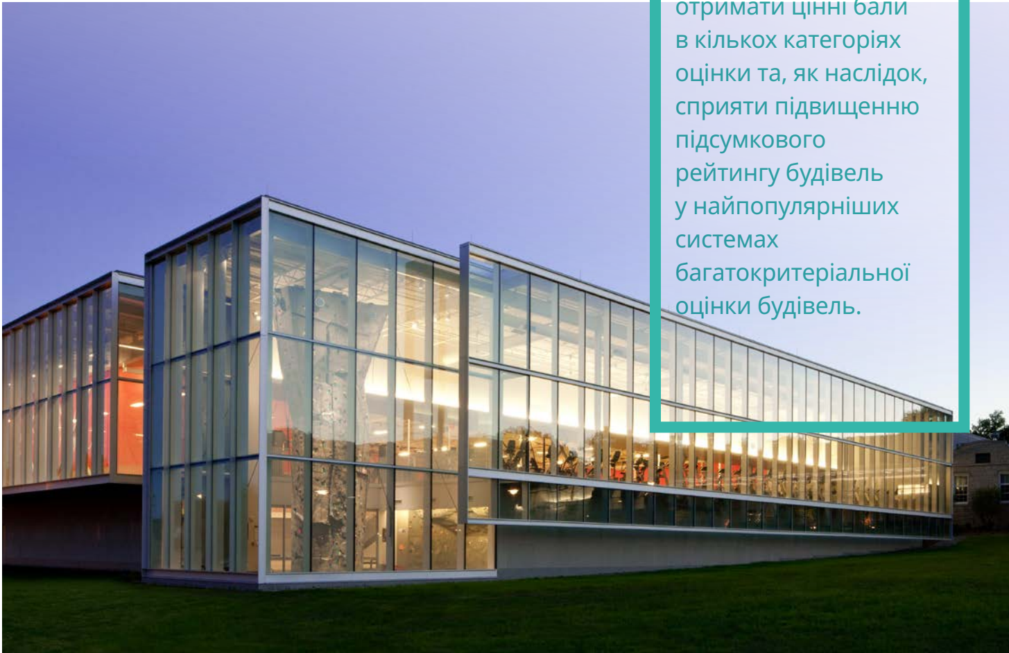
Університет Центрального Міссурі, Уорренсбург, США, 2011, LEED на рівні Gold
