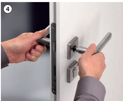
4 Зістикуйте ручки і затягніть гвинтом з внутрішнім шестигранником.
