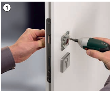
1 Встановіть і закріпіть підконструкцію.
