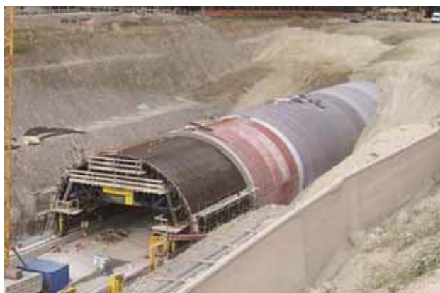
Тоннель Нойфельд, г. Берн, Швейцария
