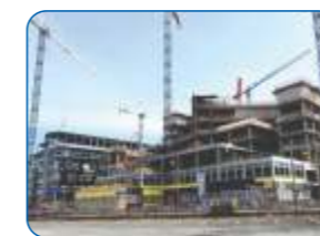
建筑工地 Construction sites
