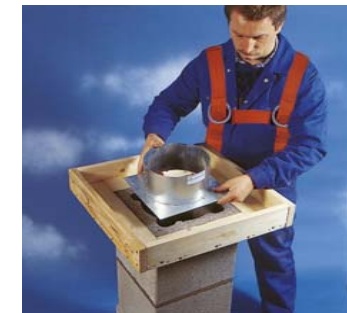
Застосування металевої манжети для заливки покривної плити за місцем.
