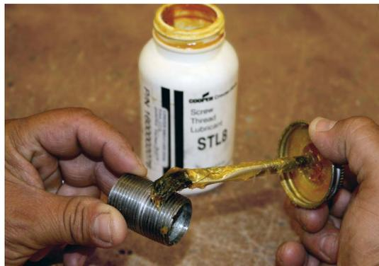
**Figure 3-4** Applying conduit lubricant
