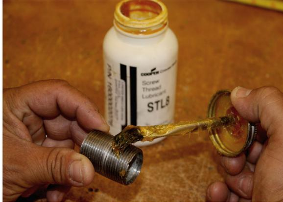
**Figure 3-5** Applying conduit lubricant
