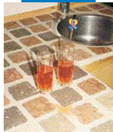
Пример приклеивания плитки и заполнения швов на кухонной рабочей поверхности
