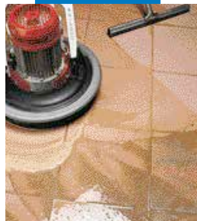
Отделка кафельного пола с помощью однодисковой затирочной машины или резинового ракеля
