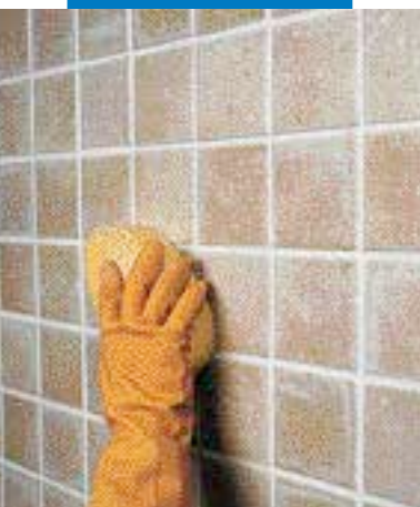
Финишная отделка плитки обычного обжига с помощью целлюлозной губки
