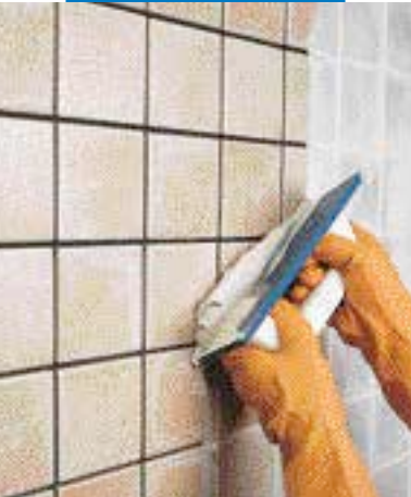
Заполнение швов в плитке обычного обжига с помощью резинового шпателя
