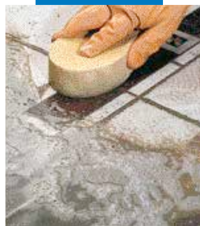
Заполнение швов в напольной керамической плитке со вставками из дерева с помощью целлюлозной губки
