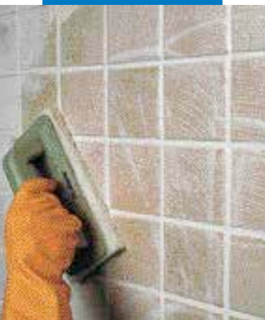
Финишная отделка плитки обычного обжига с помощью Scotch-Brite®
