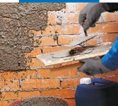
Набризковий шар штукатурки, змішаної з Planicrete
