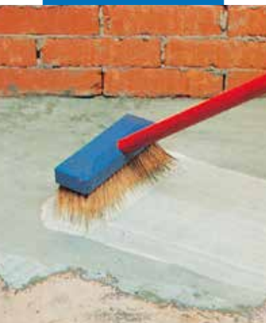
Нанесення адгезійного розчину з Planicrete
