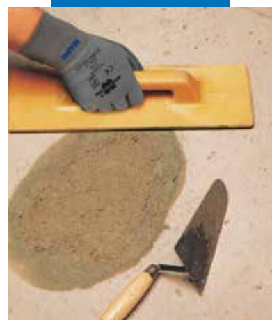
Ремонт підлоги: фінішне вирівнювання
