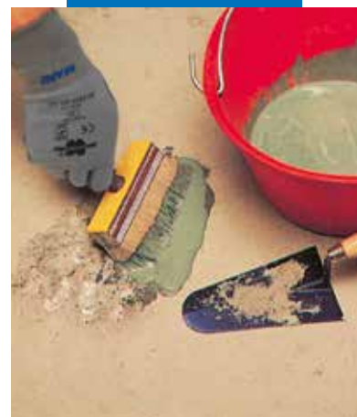
Ремонт підлоги: нанесення адгезійного розчину
