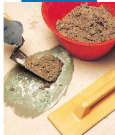
Ремонт підлоги: нанесення вирівнюючого розчину
