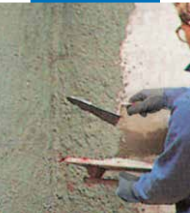
Адгезійна штукатурка, змішана з Planicrete
