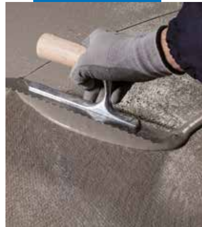
Нанесение второго слоя Mapelastich Turbo поверх первого слоя, армированного Mapetex Sel
