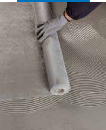
Укладка Mapetex Sel поверх первого свежего слоя Mapelastic Turbo
