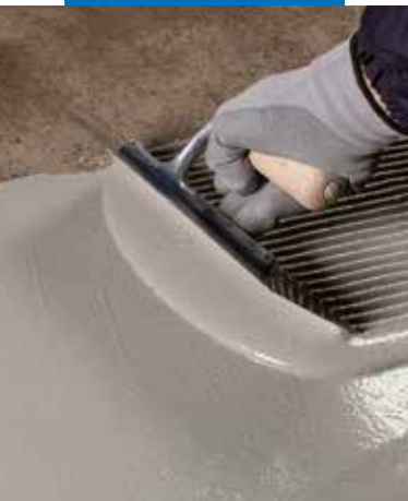
Нанесение первого слоя Mapelastic Turbo
