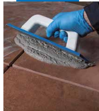
Заполнение швов с помощью Ultracolor Plus
