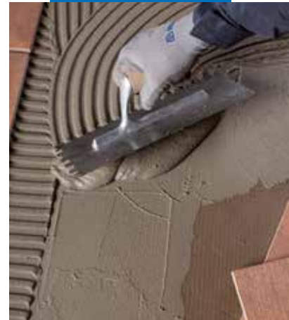
Укладка плитки с помощью Elastorapid
