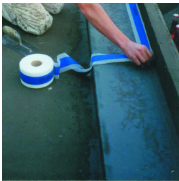
Приклад гідроізоляції кута між нижньою та бічною частиною ванни матеріалом Mapeband
