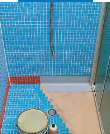
Гидроизоляция и укладка облицовки в душевой кабинке
