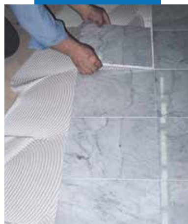
Укладка мрамора Сагга на деревянное основание, используя белый Keralastic
