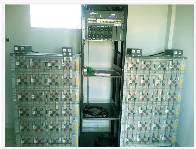
**Герметизированные необслуживаемые свинцово-кислотные аккумуляторы клапанно-рекомбинационного типа серии Modular Max (V.R.L.A.)
