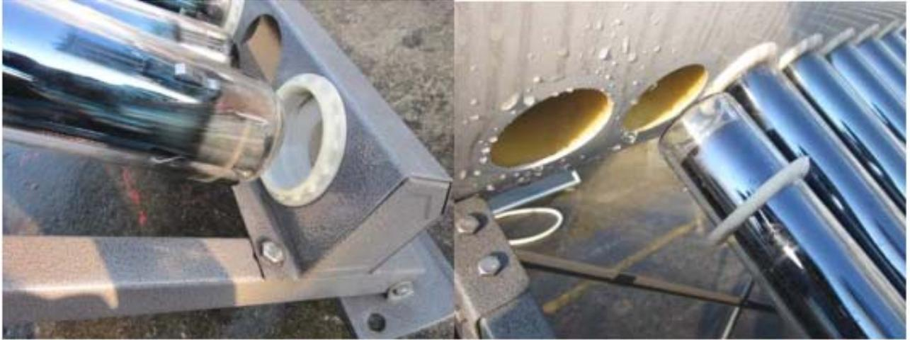
5. Нижний ниппель вакуумной трубки очень хрупкий, будьте особенно внимательны при установке трубы, чтобы не повредить его. Если ниппель или труба сломается, это приведет к утечке вакуума и повреждению трубки.
