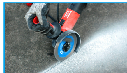
Резка бетона
