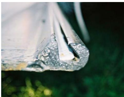
Р-201А в замку перед монтажем
