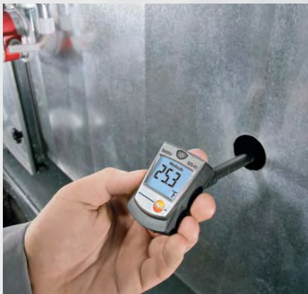
Мониторинг влажности воздуха в вентиляционном канале
