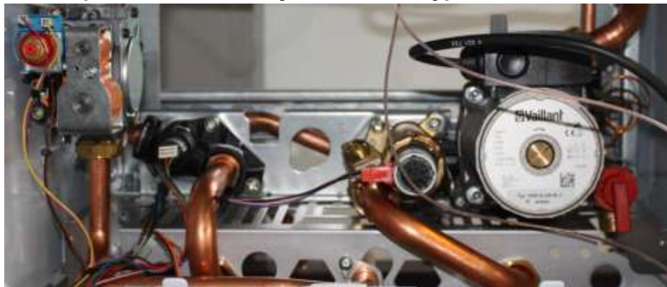
Гидравлический модуль одноконтурного котла VU
