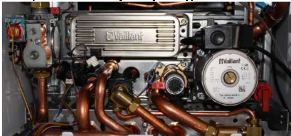
Гидравлический модуль двухконтурного котла VUW
