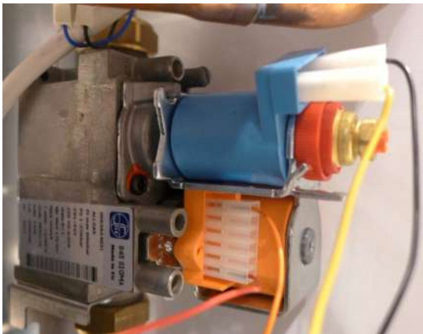
Газовый клапан SIT с пневматическим регулированием смешения газ – воздух.
