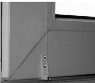
Рис. Установленный кронштейн без крышки
