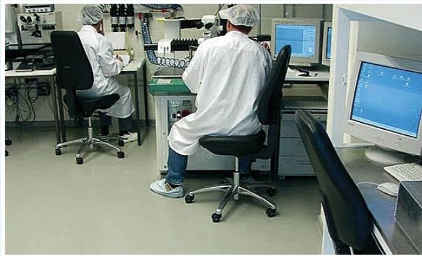
Антистатические полы — это наливные полы, препятствующие накоплению статического электрического заряда. Заряд распределяется по поверхности, или отводится на систему заземления.
