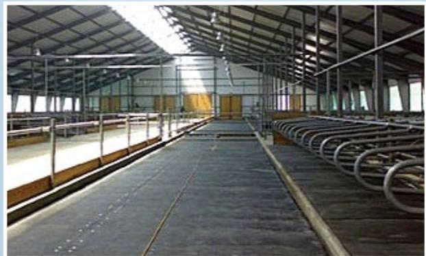
Полы для сельскохозяйственного сектора (сельхоз полы) должны обладать бесшовной конструкцией, иметь стойкость абразивным и вибрационным нагрузкам, высокую химическую устойчивость, стойкость к перепадам температур, водонепроницаемость, обеспечивать удобство в уборке и дезинфекции.
