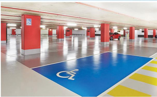
Наиболее подходящим вариантом, для паркинга являются наливные полимерные покрытия (эпоксидные или полиуретановые). Полимерные покрытия — это идеальный вид пола с точки зрения износостойкости и стойкости к маслам и бензину. Полимерные составы позволяют выполнить поверхности различной фактуры (от гладкой до шероховатой).
