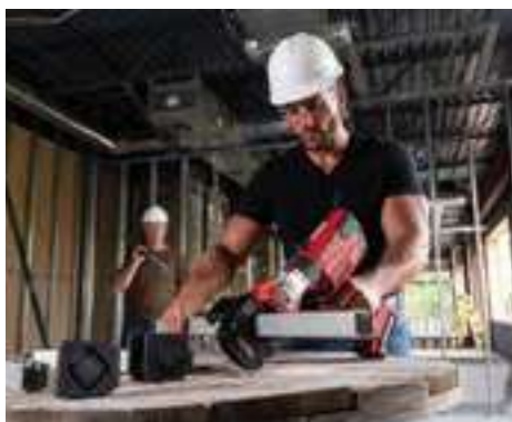
Насадка Strutslayr с пресс-пистолетом RIDGID RP 350-B
