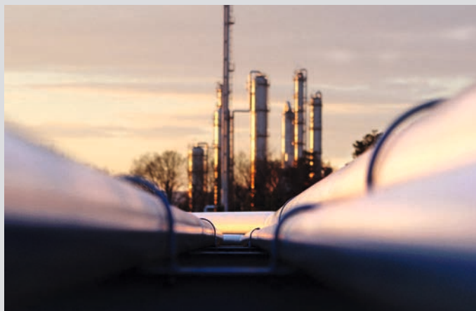
Тяжелые трубопроводы различного назначения часто монтируют к сварным металлоконструкциям.
