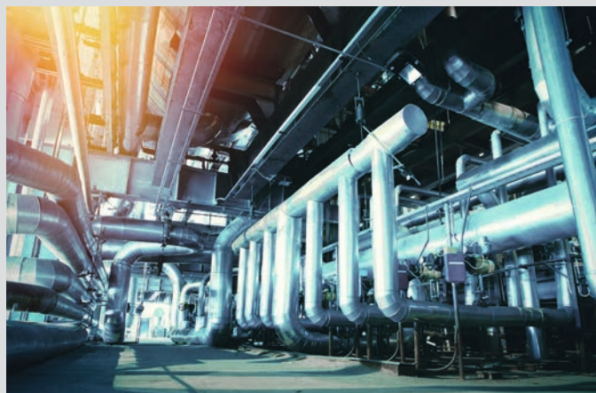
Вспомогательные сварные металлоконструкции устанавливаются в процессе монтажа тяжелых трубопроводов или кабель-каналов и часто включают в себя площадки или мосты, которые используются для обслуживания коммуникаций.
