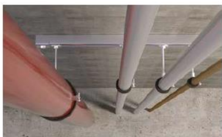
Подвесной монтаж магистралей
