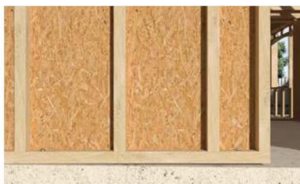
Регулировка деревянной обрешетки
