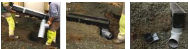
Установка песколовки
