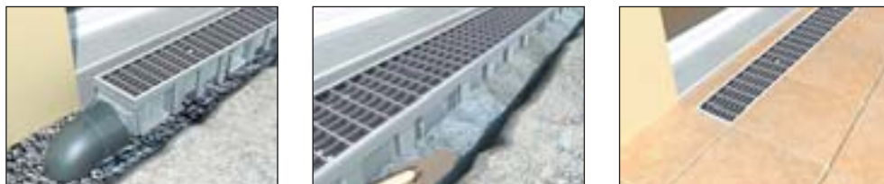
Бетонирование и укладка покрытия
